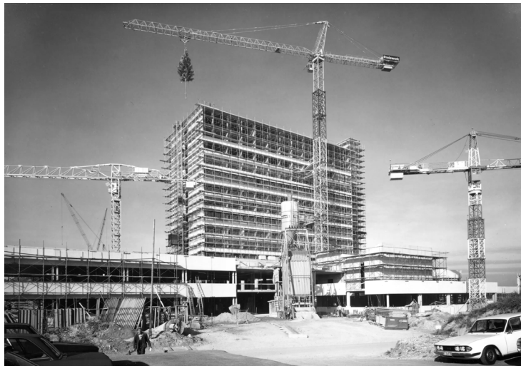
Rohbau des Bettenhochhauses
